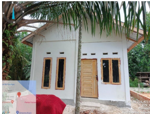
Gambar 3.3 Bantuan Rumah Layak Huni di Kel. Purnama, Kec. Duma Barat Sumber: Dokumentasi Dinas Perkim, 2024
